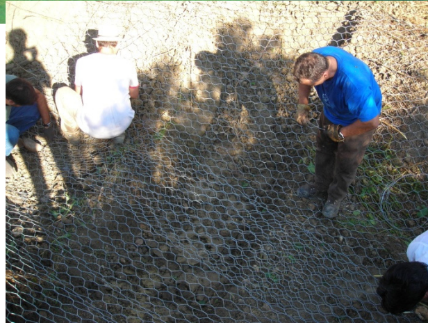
Extendido malla doble
