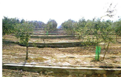
Foto 4: Obra civil para evitar formación de cárcavas.
